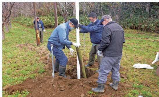
設置作業の様子
