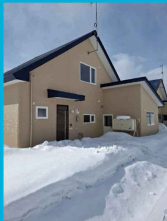
農業研修生用住宅（外観）
