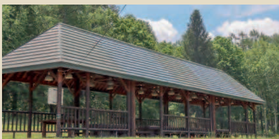
▲バーベキュー棟外観
