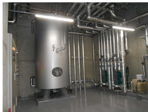
図表3 蘭越町交流促進センター幽泉閣温泉排湯ヒートポンプシステム
