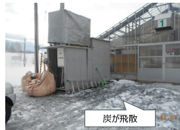
燃焼における炭の飛散状況
