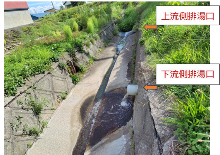
上流側排湯口、下流側排湯口と排湯路
